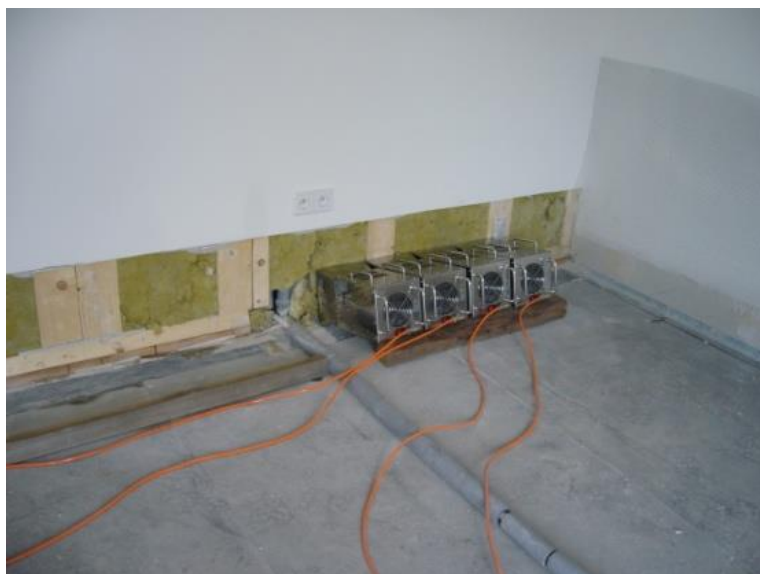
Obrázek 4 Mikrovlnné vysoušení prvků s vyšší vlhkostí
