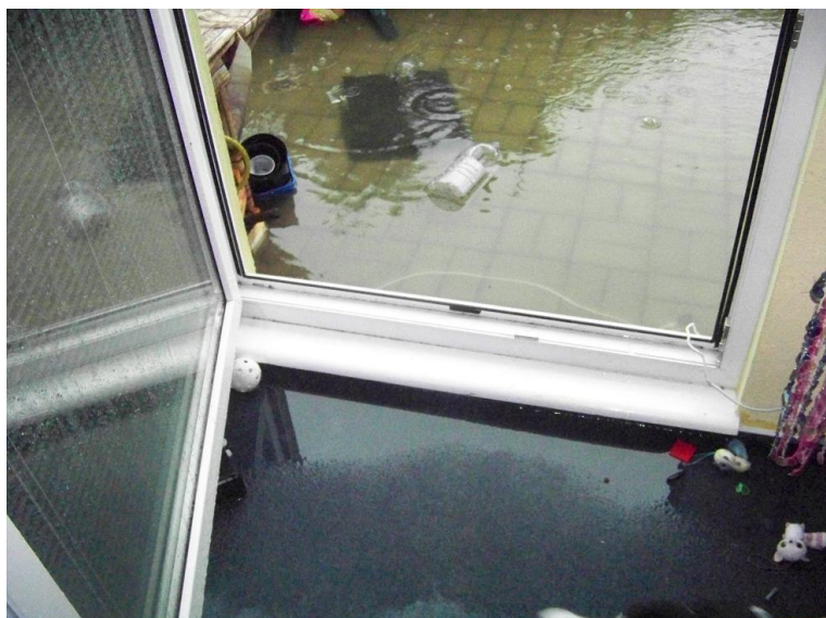
Obrázek 2 Nedostatečná kapacita jímky při přívalovém dešti
